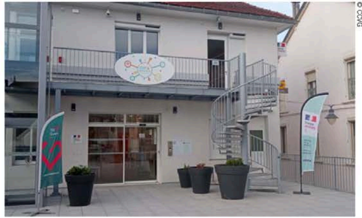
L'Espace France Services du Val Guiers, à Saint-Genix-les-Villages, a rouvert ses portes il y a peu après neuf mois de travaux.
